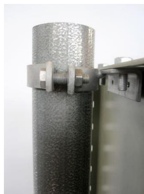
Yleiskiinnike-lamelliinnitys sivulta
